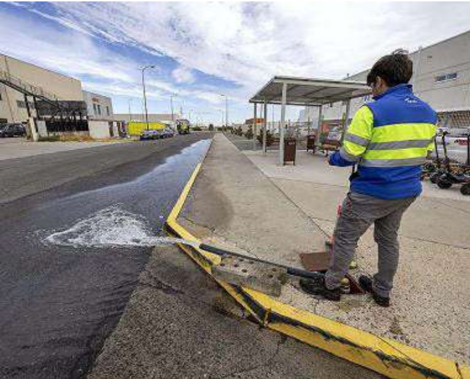
Tareas de vaciado de tuberías en el polígono de Vicolozano. / DAVID CASTRO
