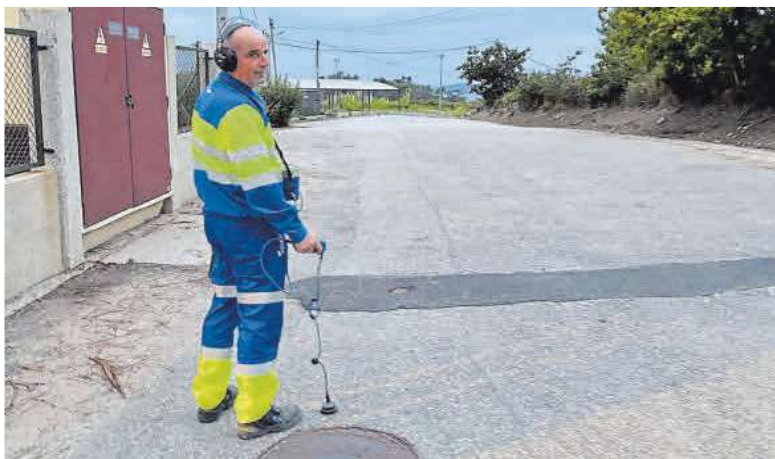
El experto en localización de fugas de Aqualia, en plena faena en la zona de Condomínguez, en Priegue.
