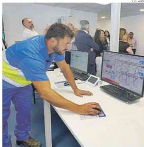
Un técnico de Aqualia en las instalaciones de la potabilizadora.
